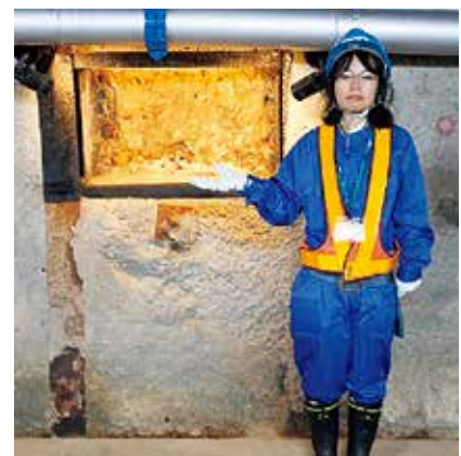
写真2 深度250m調査坑道の岩盤
